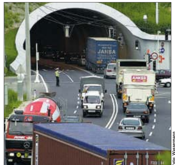
Verstopfter Tunnel: Ausweichverkehr in Wohngegenden
